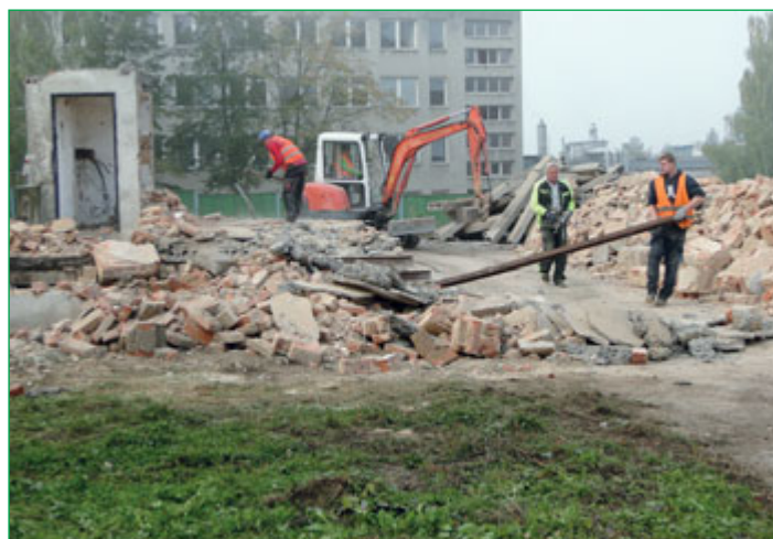
Bourání promítací kabiny v bývalém letním kině. Foto: Marie Machková
