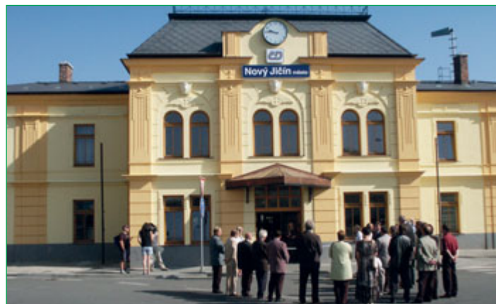
Otevření novojičínského Schwarzova nádraží po obnově v roce 2004.
