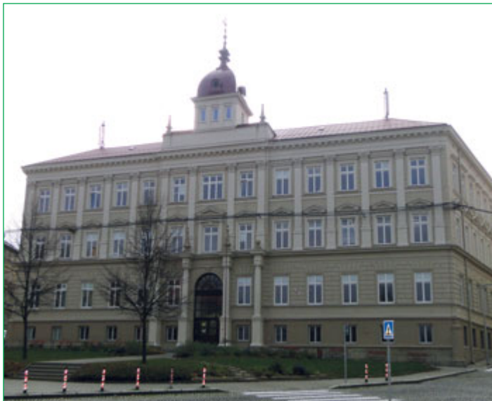
Škola Tyršova dostala novou fasádu a střeche. Foto: Marie Machková
