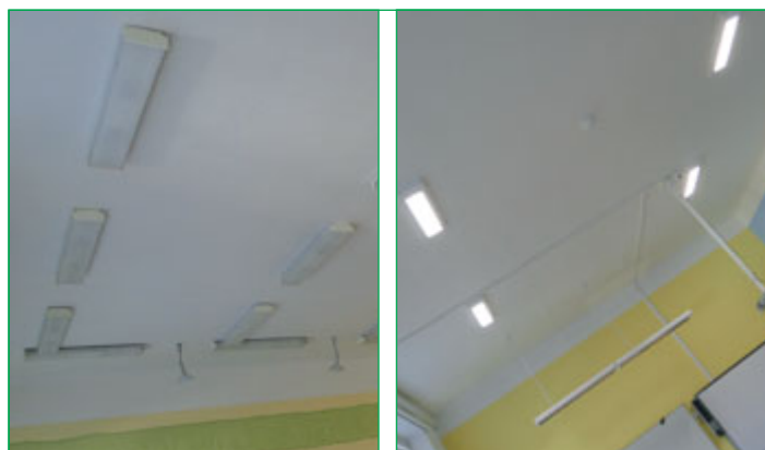
Rekonstrukce elektroinstalace v Základní škole Komenského 68. Mění se nejen rozvody, ale i staré zářivky za svítidla s LED diodami. Za opravu elektroinstalace a úspornější osvětlení ve škole Komenského 68 město zaplatí přes dva miliony korun. Letošní etapa je v pořadí již druhá.
