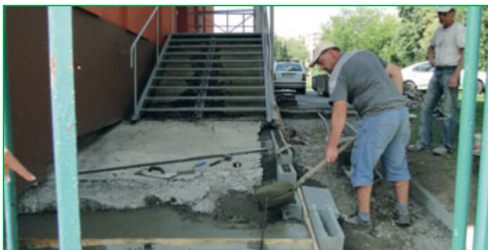
Oprava schodiště a stavba nového chodníku u bočního vstupu do jídelny Základní školy Jubilejní.
