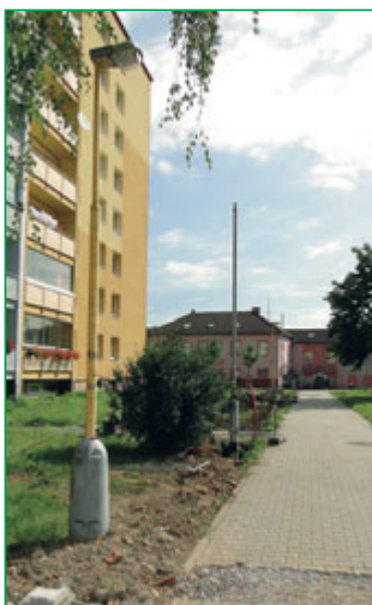
Výměna zastaralého veřejného osvětlení na sídlišti Riegrova.
