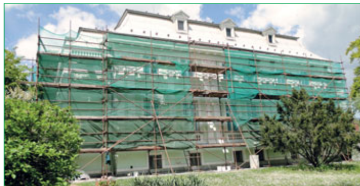
Oprava poškozené omítky představuje další etapu rekonstrukce knihovny.
