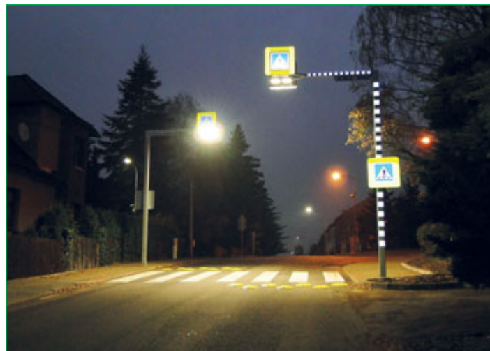
Stavebním zásahem vzniklo bezpečné místo pro přecházení silnice.
