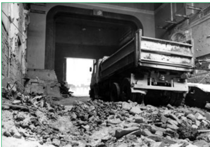
Těžká stavební technika při generální rekonstrukci na konci 80. let.
