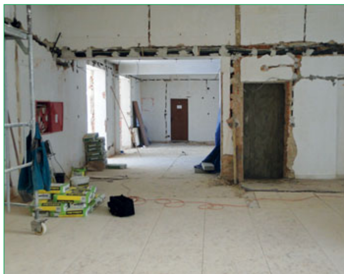
Obnova Hotelu Praha pokračuje do další fáze.
