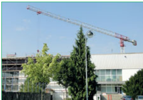
■ Začala obnova sportovní haly a bazénu.
