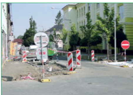
■ Začátek rekonstrukce Komenského ulice.
