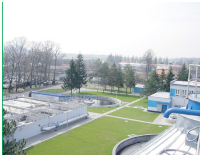
Moderní areál novojičínské čistírny odpadních vod. Foto: archiv Sm VaK
