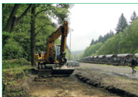
■ Začala stavba cyklostezky do Hostašovic.
