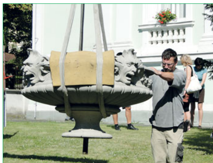
Opravenou vázu musel na podstavec usadit jeřáb.
