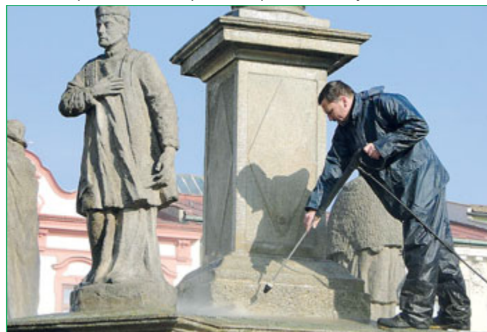
Restaurátor Jakub Gajda smývá nečistoty proudem tlakové vody.
