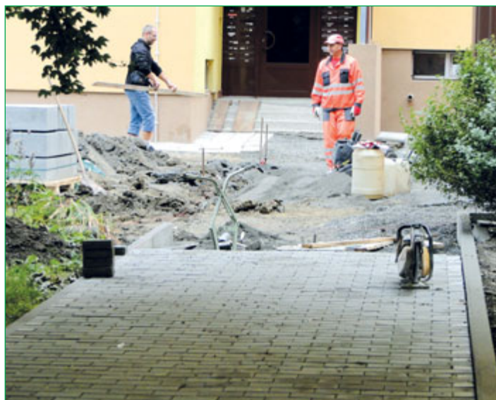
Součástí první etapy revitalizace sídliště byl nový chodník na Sportovní ulici. Foto: Marie Machková
