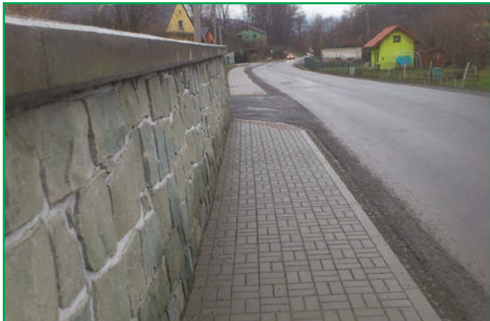
Nový chodník výrazně zvýší bezpečnost chodců. Foto: Marie Machková
