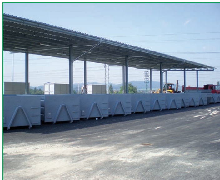
Obyvatelům Nového Jičína začal sloužit nový separáčnický dvůr.
