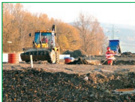
■ Začala stavba separačního dvora.
