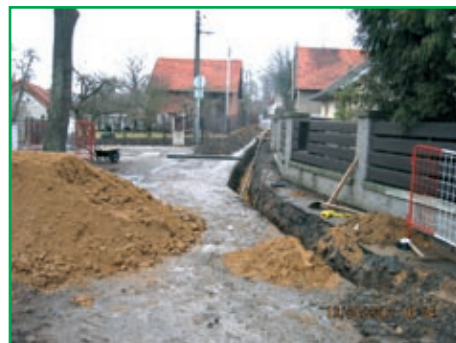
■ Nová kanalizace v Loučce.
