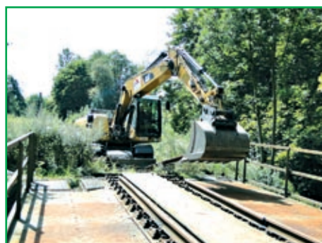
■ Na budoucí cyklostezce vytrhali koleje.
