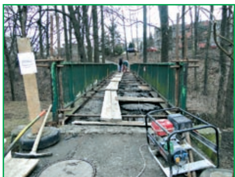
■ Oprava lávky na Lamberk.
