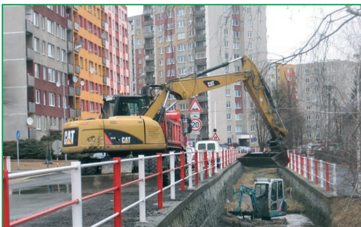
Odstraňování povodňových škod
