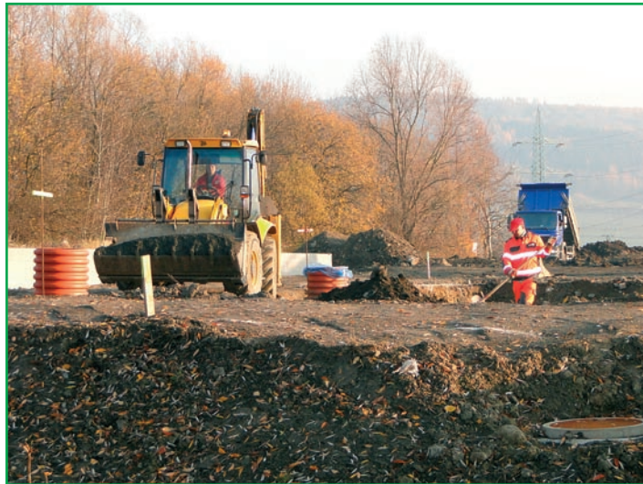
Stavba separačního dvora potrvá do května příštího roku.
