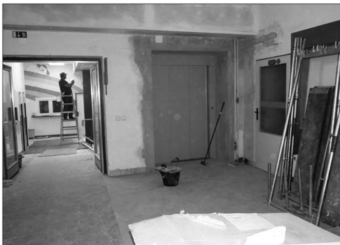
Ve Fokus byl postaven nový výtah
