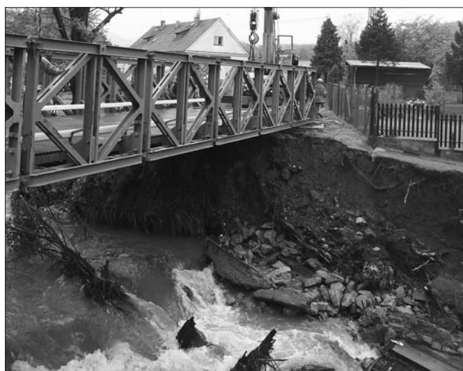
Jeřáby posunují most přes Zrzávku na bezpečnější místo.
