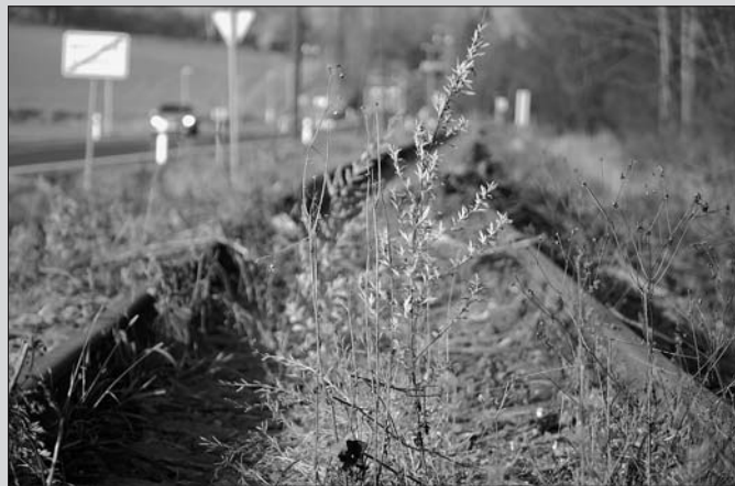
Železnice z Nového Jičína do Hostašovic má stále více na kahánku.
