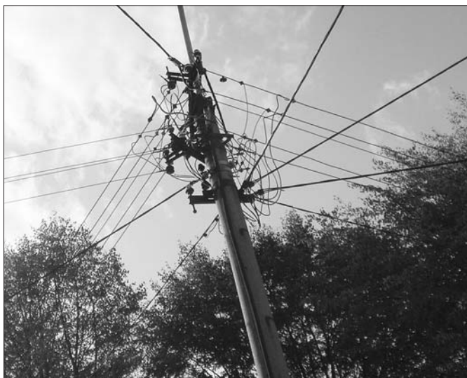
Paručína elektrického vedení před položením do země.
