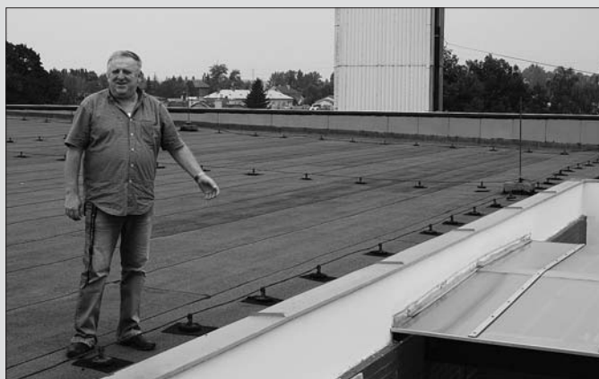
Vedoucí areálu Milan Dvořák na střeše krytého bazénu.
