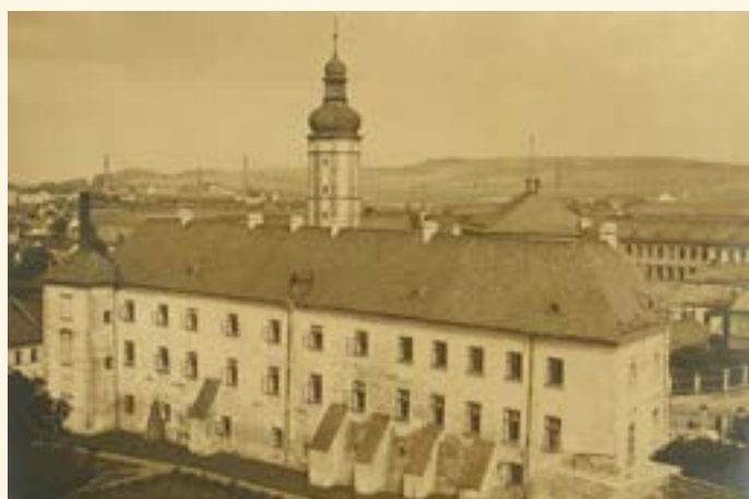
Frantz Alexander Neumann, opěrní pilíře SZ křídla zámku vybudované při přestavbě.
