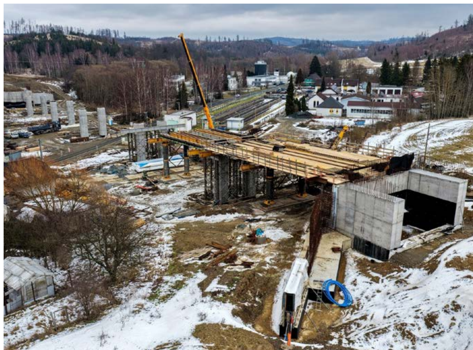
Ředitelství silnic a dálnic pravidelně zveřejňuje záběry ze stavby východního obchvatu Bruntálu.
