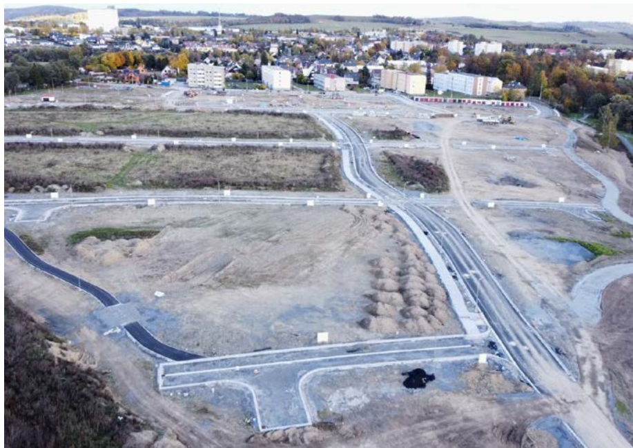
Infrastruktura nezbytná pro výstavbu domů v lokalitě Za Mlékárnou by měla být dokončená letos.
