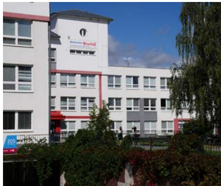
Bruntálská nemocnice má nového provozovatele a také nový název. Foto: zup
