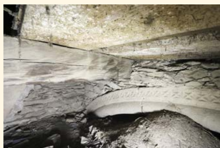
Horní část portálu pod podlahou 1. patra věže.
