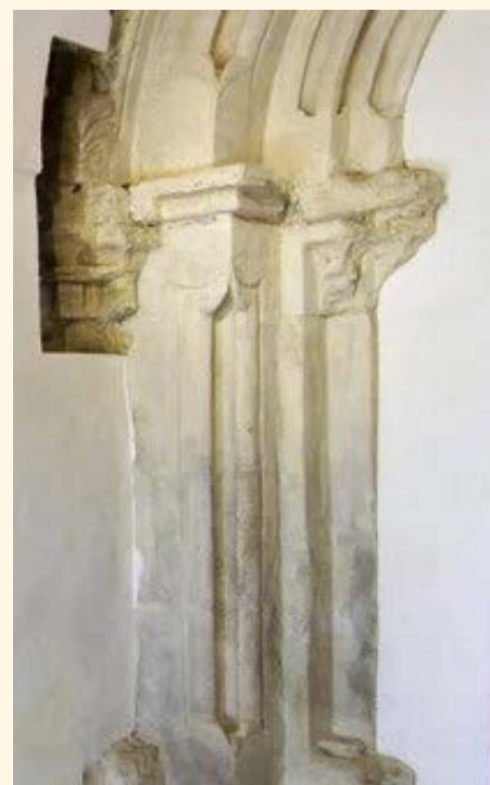
Odkryv zazděných částí portálu pod věží.
