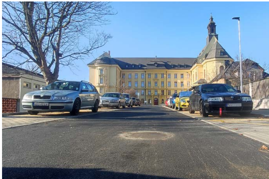
Úsek komunikace u Petrína je hotov, má finální povrch a také veřejné osvětlení.
