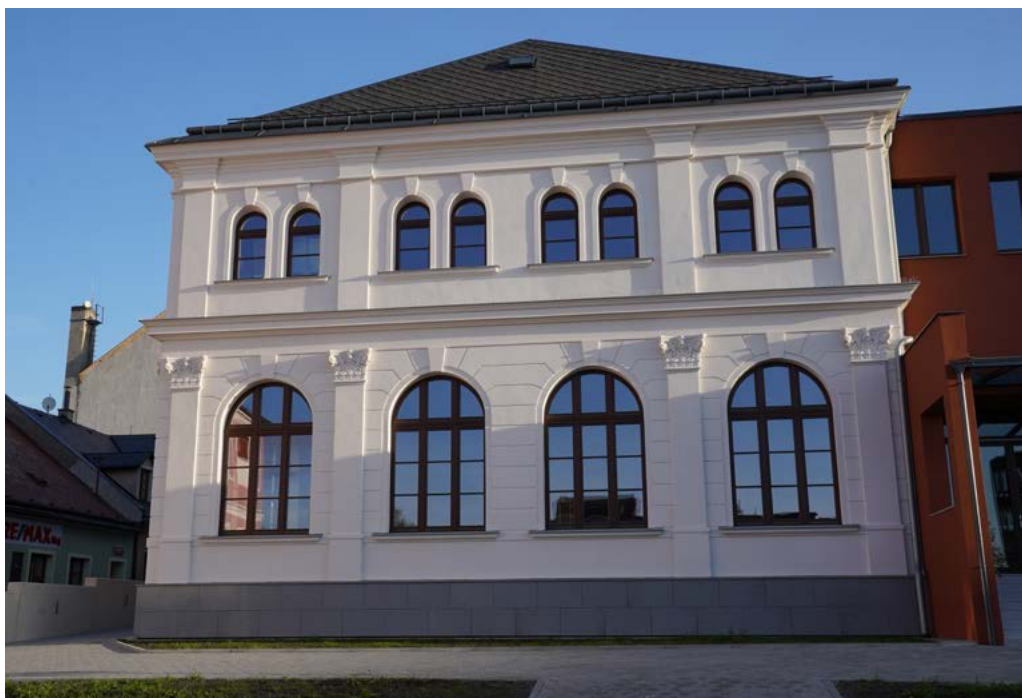
Městské divadlo je po rekonstrukci opět v provozu. Po komplexní revitalizaci fasád má zpět historizující vzhled.
