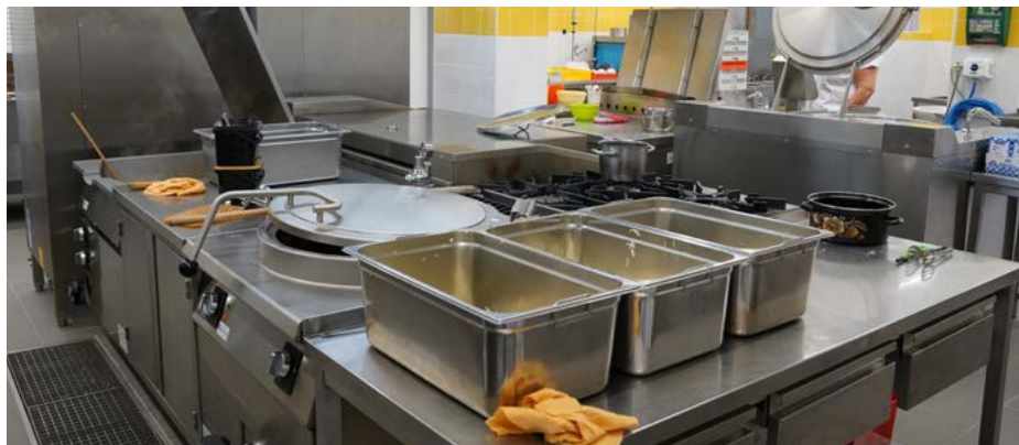
Část kuchyně ZŠ Bruntál, Cihelní 6, Bruntál po rekonstrukci.
