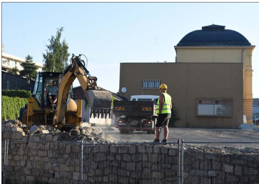
Minulý týden začala rekonstrukce autobusového nádraží pod Společenským domem. Zastávky byly dočasně přemístěny. Foto: zup
