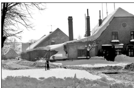
Bílé střechy a sněhová peřina na Nádražní ulici v roce 1970.
