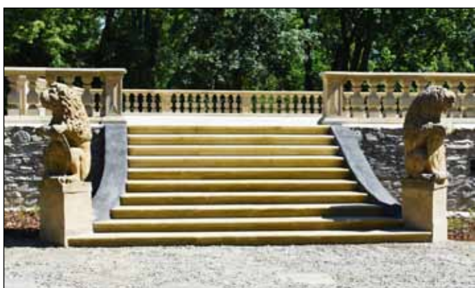
Unikátní stavba prošla kompletní rekonstrukcí. Opraveny byly také horní terasy.
