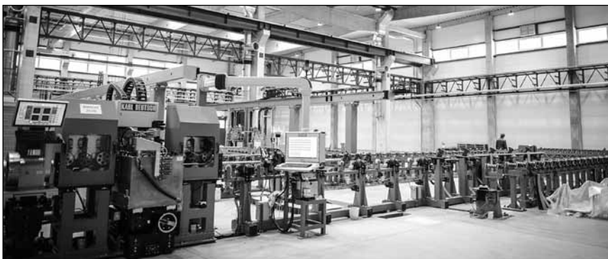
Po dvouleté fázi plánování a výstavby byl v Bruntálu otevřen nový závod společnosti Strojmetal Aluminium Forging s.r.o. Výstavba nové továrny si vyžádala investici dosahující téměř jedné miliardy korun. Práci zde najdou stovky lidí různých profesí.
