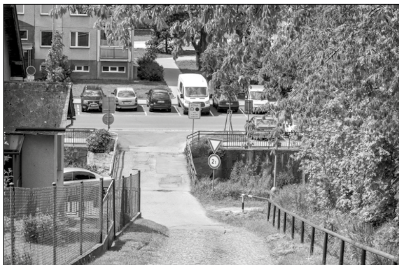
Most přes Černý potok se dočká opravy. Rekonstrukce by měla začít v létě.
