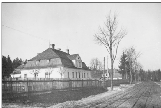
Hájenska Řádu německých rytířů ve Skrbovické ulici (dnes Zahradní, naproti budovám OSRAM).
