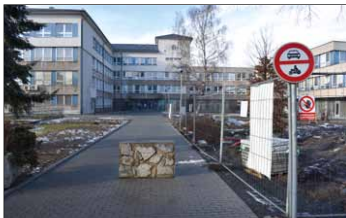
Rekonstrukce prostranství před nemocnicí bude dokončena na jaře. Vchod do polikliniky je již zpřístupněn. Foto: zup
