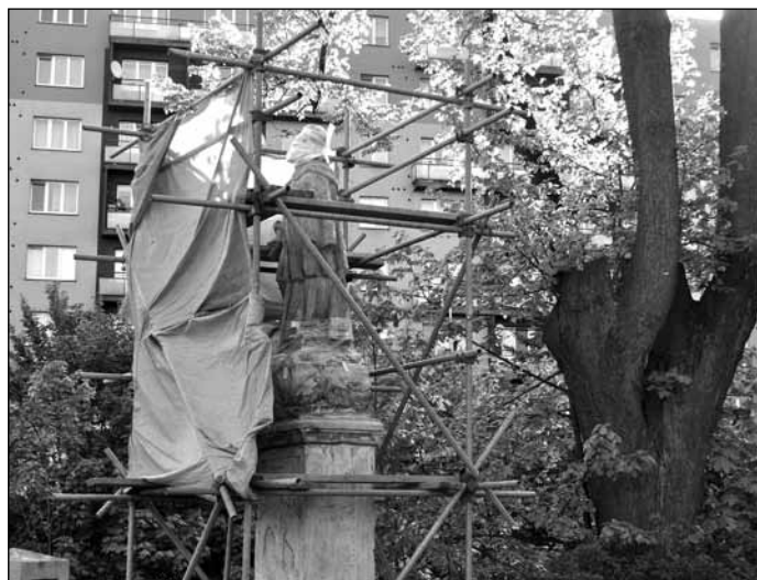
Socha sv. Jana Nepomuckého prochází rekonstrukcí.
