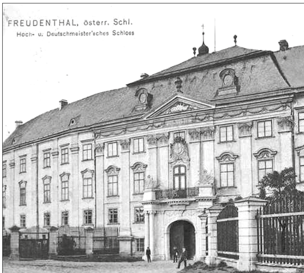
Zámek Bruntál – malá okna v levé části osvětlovala divadelní sál.
