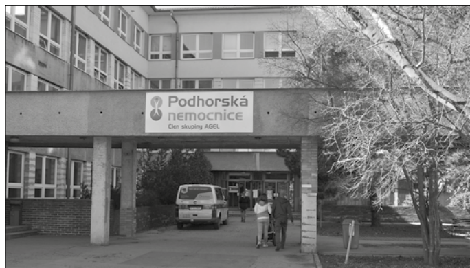
Opravy prostranství před nemocnicí zahájí demolice vstupního portálu.
