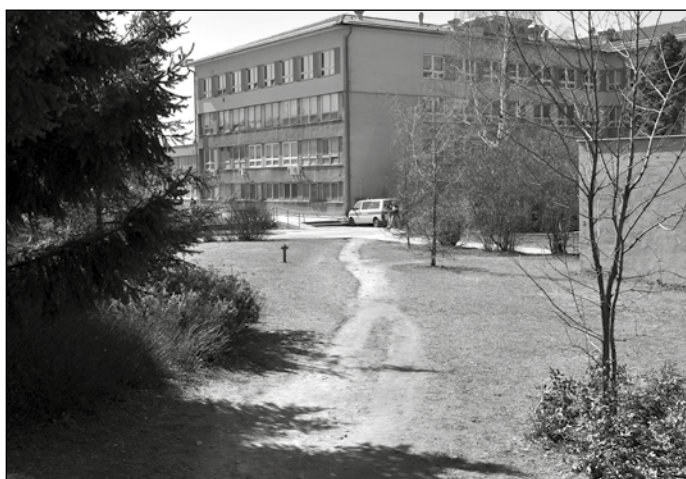
Opravy vstupu do nemocnice zahrnou také chodník, který vede k supermarketu. Ten zůstane zachován.
