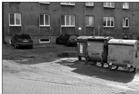
Opravovat by se mělo také stání za bytovými domy ve Fügnerově ulici. Foto: zup
