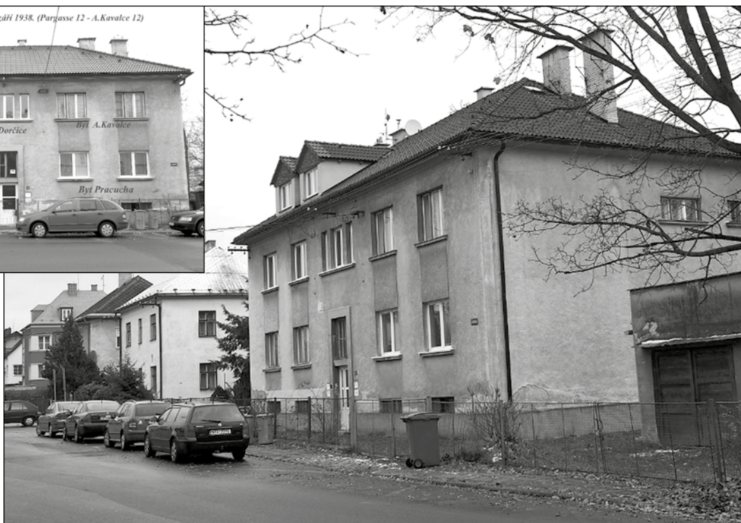
Bytový dům na dnešní Kavalcové ulici byl postaven pro československé úředníky.
