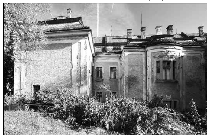
Bývalý okresní soud, dvorní trakt v roce 2013.
