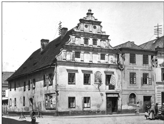
Gabrielův dům v roce 1914 bezprostředně před zahájením rekonstrukce.
