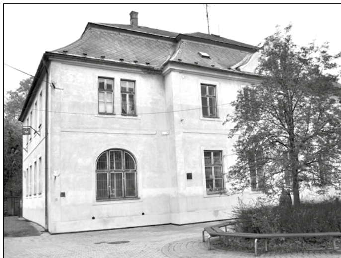
Dům dětí a mládeže – budova i přístavba vzadu.
