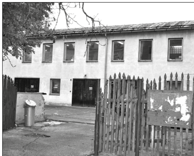
Dům dětí a mládeže – budova i přístavba vzadu.
