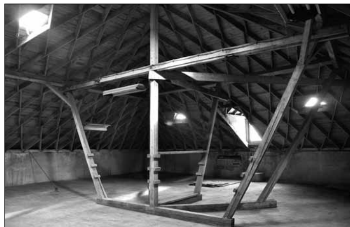
Nejen prostory fungujícího pivovaru, ale také momentálně nevyužívané patro a podkroví bylo cílem prohlídky.
