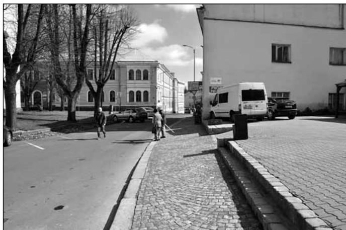
Dokončené už jsou opravy chodníku u Žižkova náměstí. Dřívější dlažbu nahradily žulové kostky. Foto: lk
