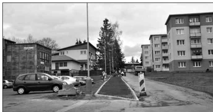
Nové parkovací plochy vznikají v Zeyerově ulici, ty dosavadní nebyly kapacitně dostačující.
