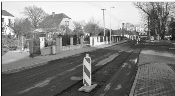
Probíhající rekonstrukce v Husově a Kavalcově ulici v Bruntále.
