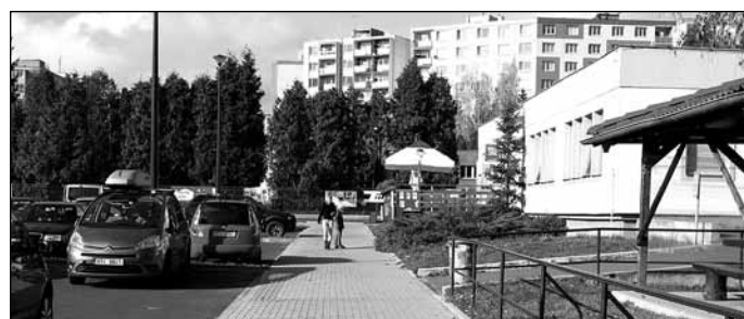
Celkem devět etap oprav je naplánovaných na sídlišti Dolní.
