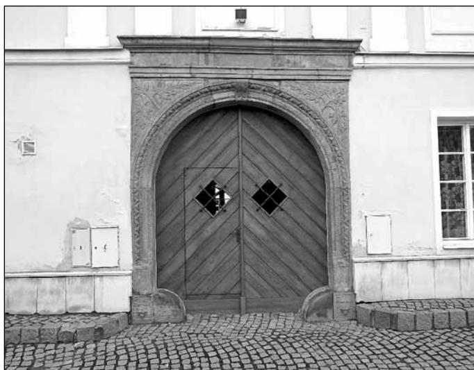
Renesanční portál hlavního vstupu.
